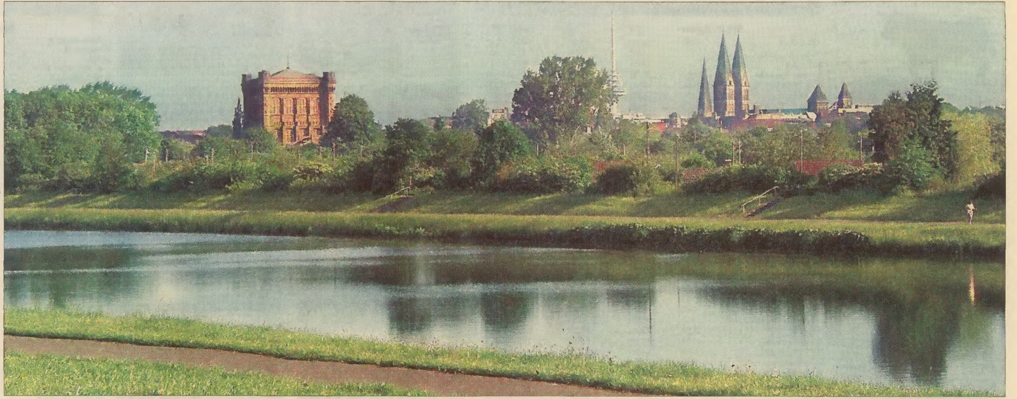
Die „umgedrehte Kommode“ vom Werdersee aus gesehen. Im Umfeld dieses Bauwerks will auch die Brebau Eigenheime schaffen.
