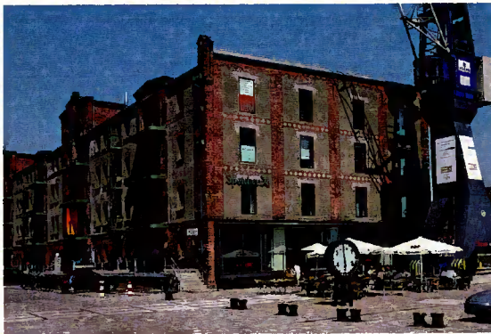
I Der Speicher XI - Standort des b.zb
