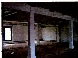
I Das b.zb zu Sanierungsbeginn
